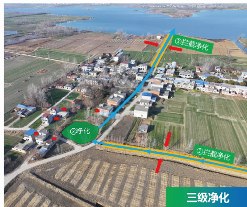
集团深度参与蚌埠市（怀远片区）农村黑臭水体治理试点项目，承接了唐集镇、兰桥镇、古城镇共14条河道的治理任务
