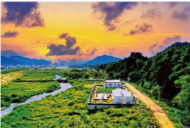
黄山市农村污水治理PPP项目(一期)工程，打造出农村污水治理市场化运作、全域化覆盖、精细化推进、循环利用和智慧化监管的“黄山模式”
