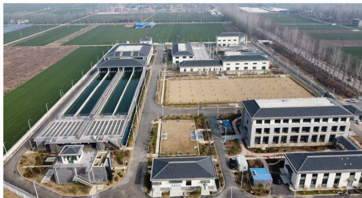
在亳州谯城区实施供排水一体化，实现“供排一体、城乡一体、厂网一体”系统化运营
