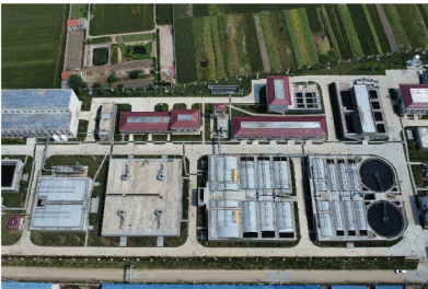
临泉县铜城工业园区污水处理厂
