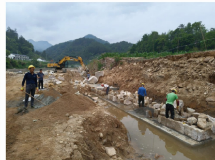
(指导驻村工作队协调推进彭家河流域西河段修复治理项目建设)
