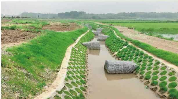
(池州十八索区域水生态治理工程现场)
