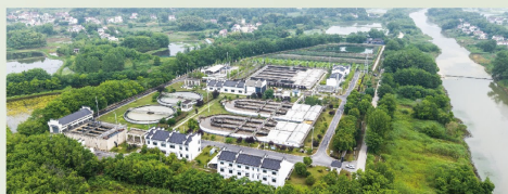
(青阳县污水处理厂)
