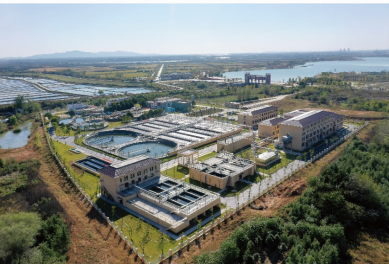
滁州市南谗新区污水处理厂，总结出一套市政污水终端处理带动前端溯源的“滁谗模式”
