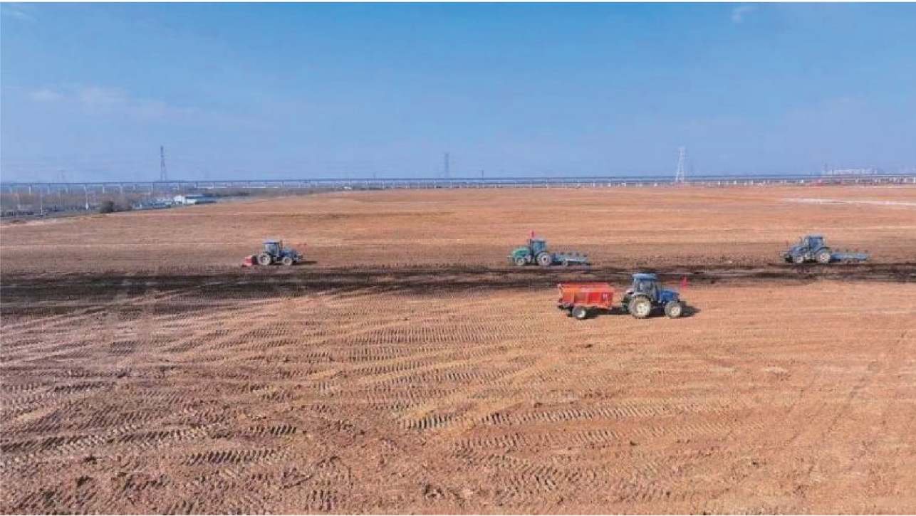
(引江济淮工程高新区2号弃渣场临时用地土地复垦项目土壤改良作业现场)
