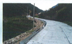
基础设施建设
