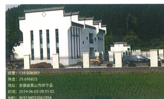
黄山市农村污水处理项目-实景图
