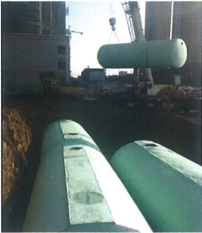
雨水收集系统施工
